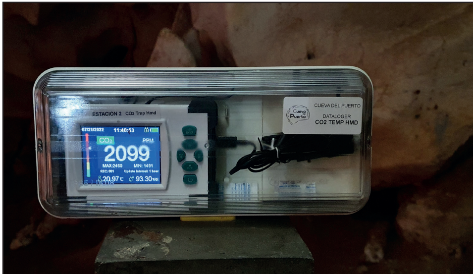
Foto 5. Equipo Carbón Dioxide Detector instalado en interior de Cueva del Puerto(período funcionamiento siete meses).
